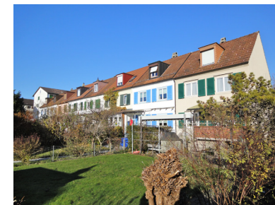
Eigenheimweg mit Wärmedämmputz
