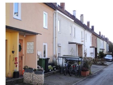
Eigenheimweg mit Wärmedämmputz
