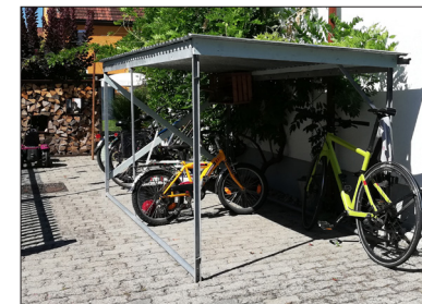
Fahrradunterstand bestehend, Material und Masse i.O.
