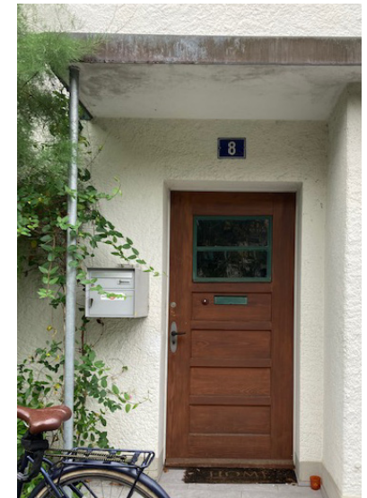
Hauseingang mit bauzeitlicher Tür
