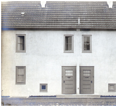
Historische Aufnahme der Strassenfassade.
