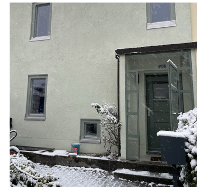
Eigenheimweg mit Wärmedämmputz
