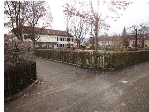
«Selbsthilfe-Kolonie», Gemeinschaftshaus und grosser Platz von N, 29.11.2013 (Bild Nr. D101125_33).
