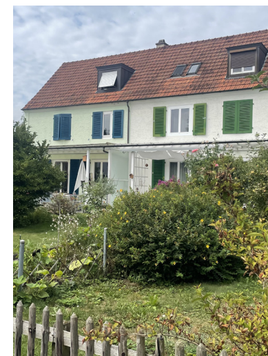
Bauzeitliche Pergola - Haustyp c
