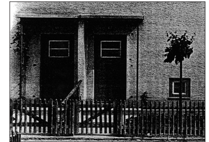
Hauseingang Eigenheimweg bauzeitlicher Zustand
