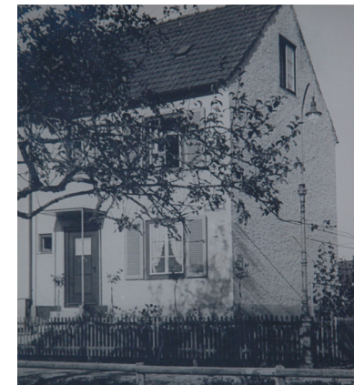
Die Häuser am Gipserweg hatten bereits zur Bauzeit ein Fenster in der Stirnfassade.
