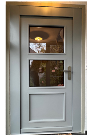
Neue Tür nach bauzeitlichem Vorbild mit mehr Glasanteil.
