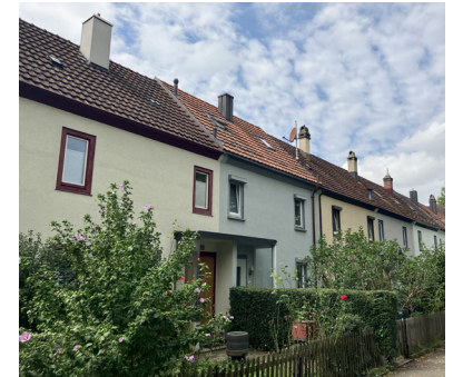
Dachdämmung Haustyp A
