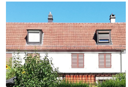
Dachfläche Haustyp C
